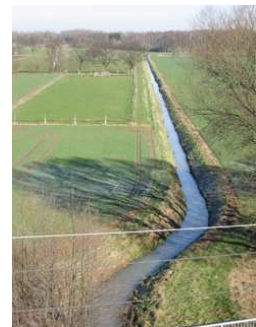
Der Hehlinger Bach unterhalb der ICE-Strecke zwischen Vorsfelde und Danndorf – ein Beispiel für einen naturfernen Bach
