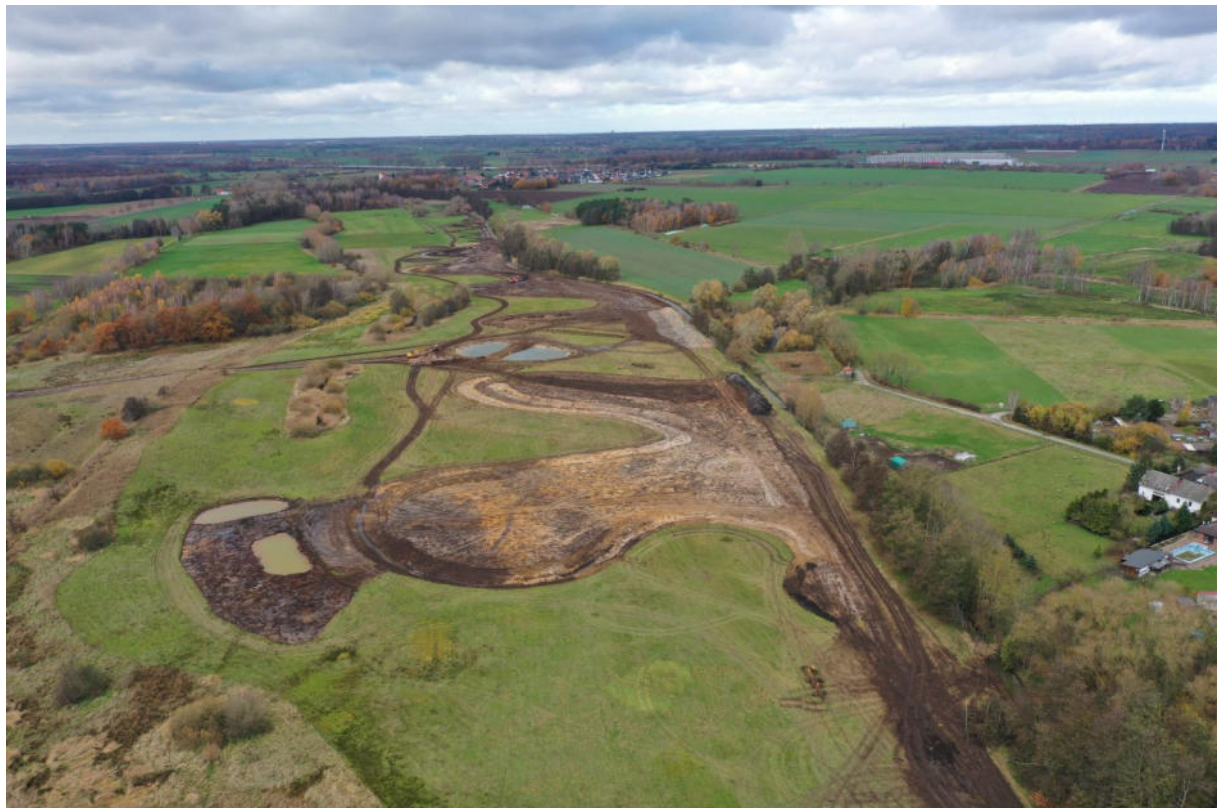
Foto oben: Bauarbeiten Ende November im unteren Abschnitt von Ochsendorf Richtung Beienrode gesehen
