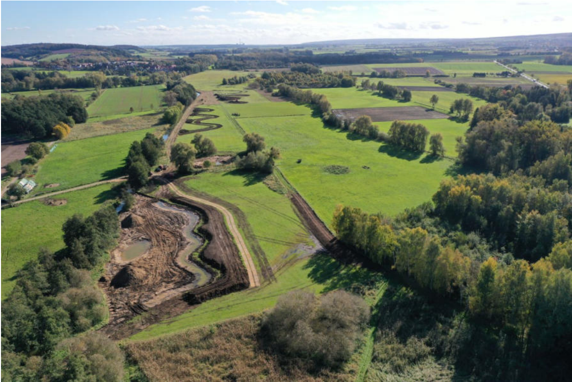
Foto oben: Bauarbeiten Mitte Oktober im unteren Abschnitt von Ochsendorf Richtung Beienrode
